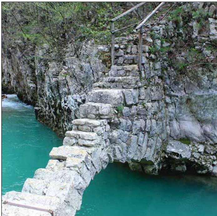
**Ponte Cusano**:il ponte ad arco di probabile fattura sannitica e costituito da enormi blocchi di pietra rimasti indenni nel tempo alle intemperie. Fino agli anni '50 il ponte è stato utilizzato per raggiungere il vecchio mulino detto "di Zi Fiore"
